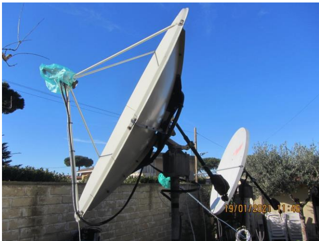
IK0HWJ: Parabola 2,4m pro 6cm a v pozadí offset parabola 1,8m pro 3cm
